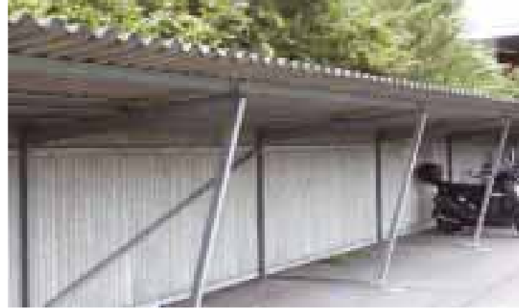
Fassaden/Dächer aus Asbestzement
