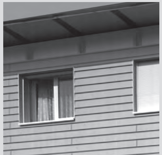
Fassadenplatten bei der Überlappung aufliegend und unsichtbar befestigt
