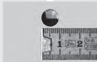
Im Werk, beim Händler oder auf der Baustelle (am Boden) vorgebohrte Befestigungslöcher \varnothing 9,5 mm in der Fassadenplatte
