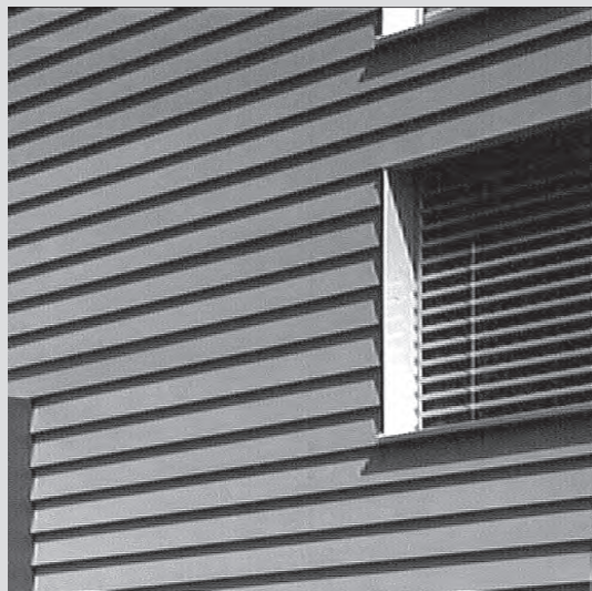
Fassadenplatten voneinander abgesetzt, Befestigung unter der Überlappung.
